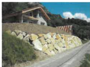
Exemple d'enrochements interdits
